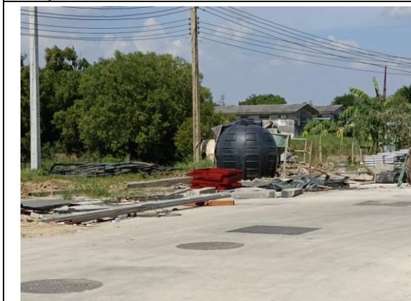
รูปที่ 29 ถังบำบัดน้ำเสียสำเร็จรูป ช่วงก่อสร้าง และแนวท่อระบายน้ำของโครงการ
