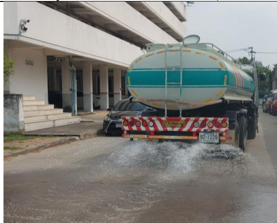
รูปที่ 4 ฉีดพรมน้ำลดฝุ่น
